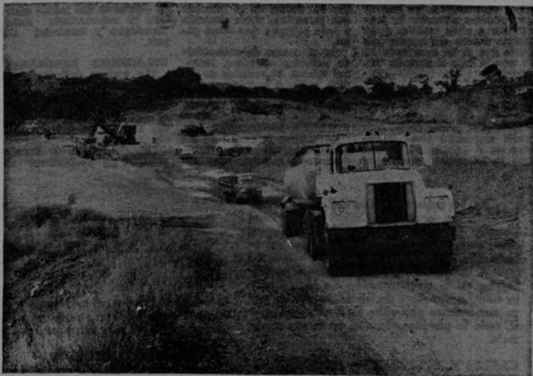
EQUIPOS EN PLENAS LABORES.
