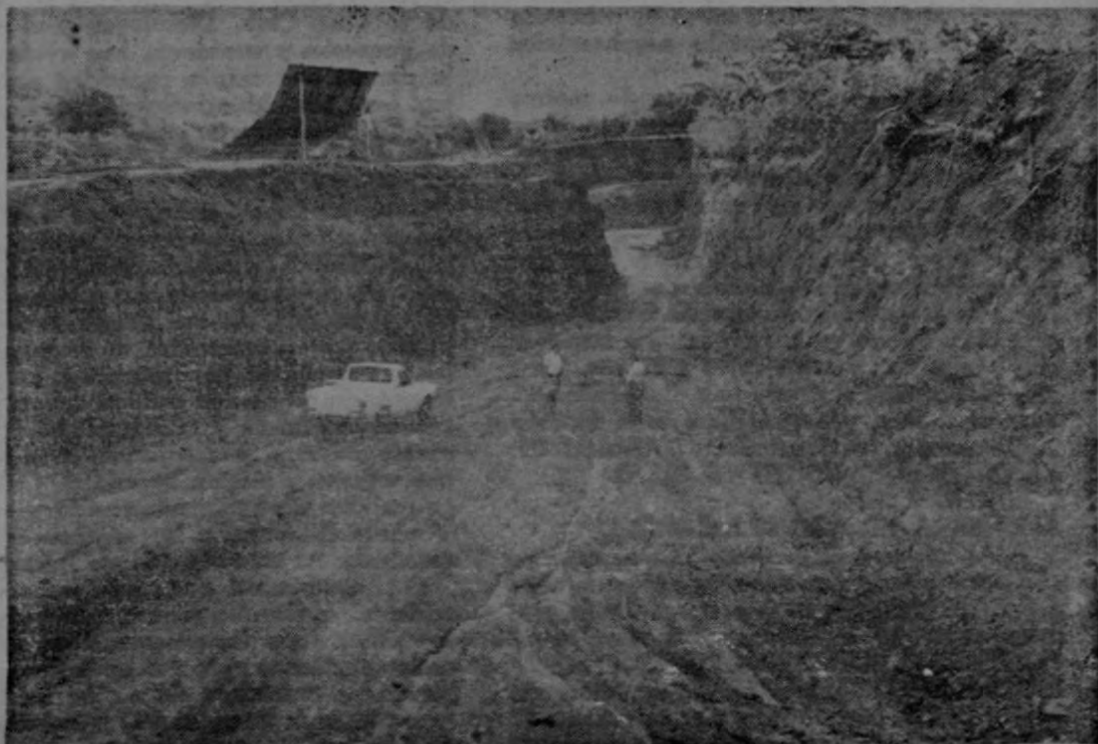
OBRAS DE DRENAJE.
