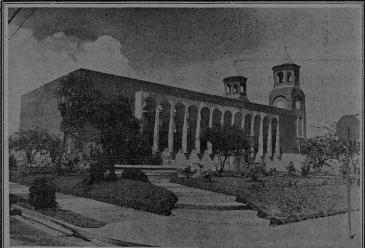
HERMOSO TEMPLO EN CONSTRUCCION DE LA BELLA CIUDAD DE SAN ANTONIO DE BELEN.
